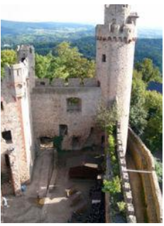
Südturm, rechts der Wehrgang. Dieser Turm diente auch als Burgverlies.
